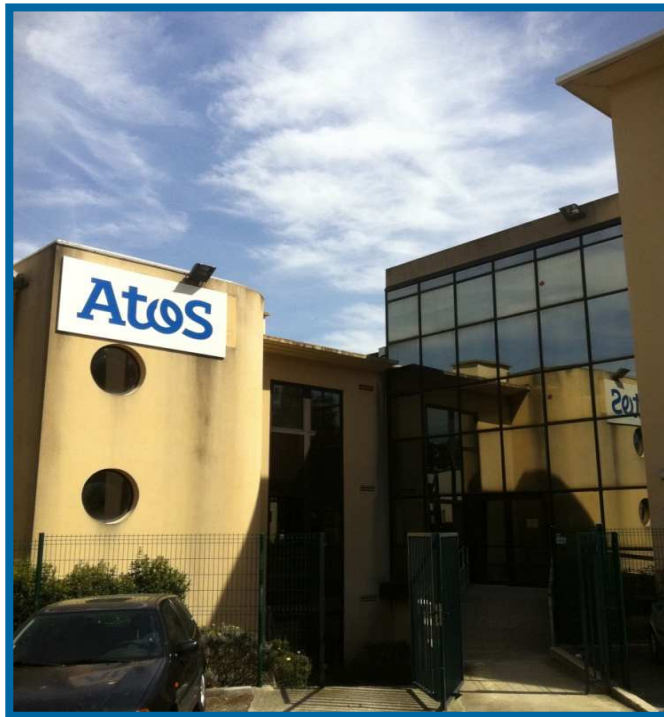
Le Millénium 3 500m2 Plateaux sécurisés
